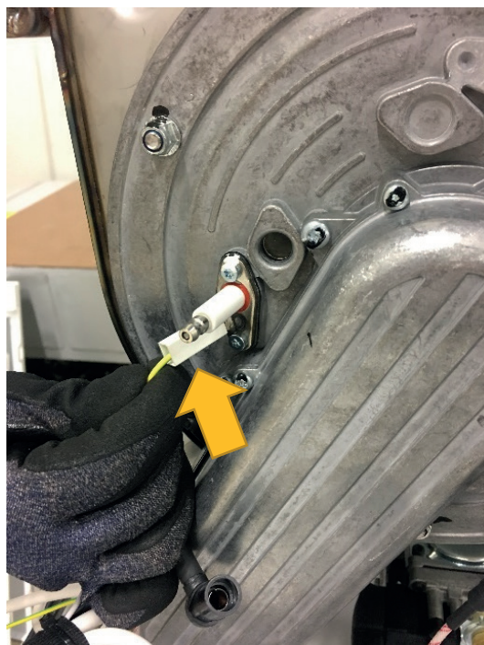
Электрод Зажигания
